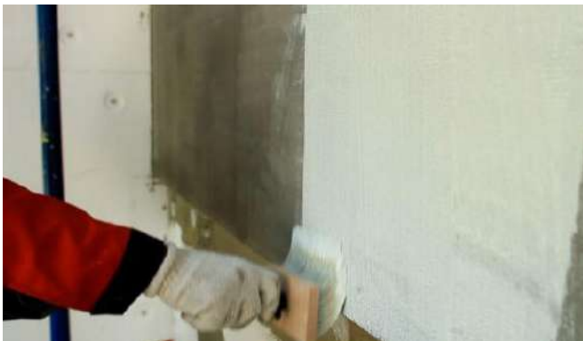
Рис. 17. Нанесение кварцевой грунтовки на поверхность базового штукатурного слоя
