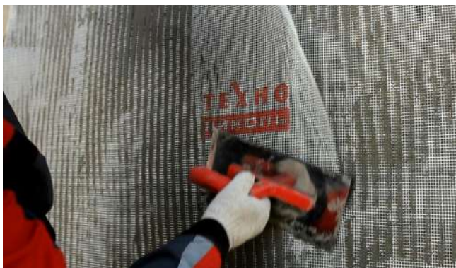
Рис. 16. Монтаж базового штукатурного слоя, армированного стеклосеткой
