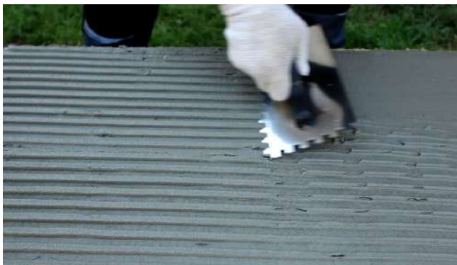
Рис. 4. Нанесение клеевого состава на плиту сплошным методом приклейки
