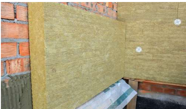
Рис. 2. Установка опорного профиля для первого ряда теплоизоляции б) с применением деревянного бруса
