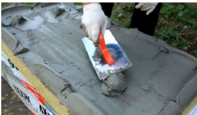
Рис. 6. Нанесение клея на плиту контурно-маячковым методом приклейки
