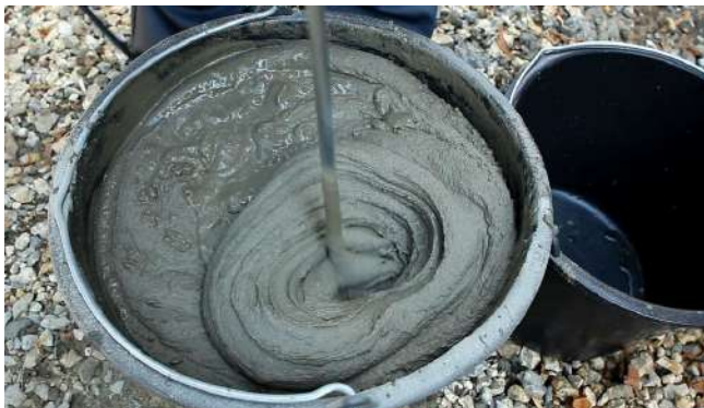
Рис. 3. Замешивание клея для приклейки теплоизоляции
