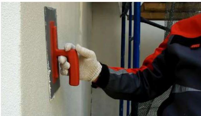
Рис. 18. Нанесение декоративного слоя штукатурки
