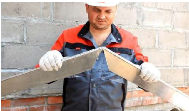
Рис. 2. Установка опорного профиля для первого ряда теплоизоляции
