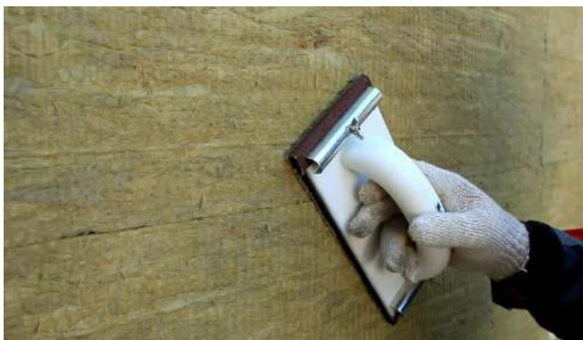
Рис. 12. Шлифовка стыков плит теплоизоляции наждачной бумагой
