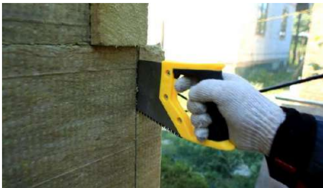
Рис. 10. Зубчатая перевязка плит на наружных углах здания
