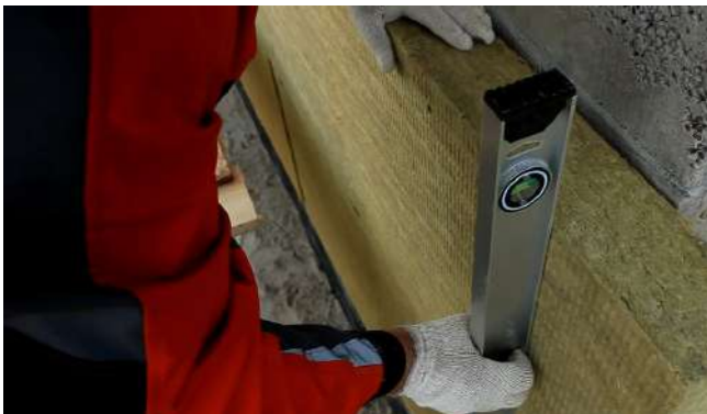
Рис. 8. Приклейка плиты тепло-, звукоизоляции к стене
