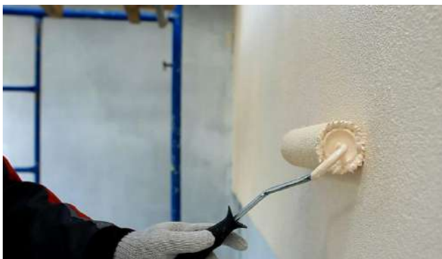
Рис. 19. Нанесение краски на поверхность фасада
