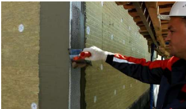
Рис. 15. Установка усиливающих профилей на углах здания
