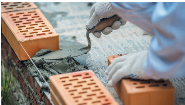
Рис. 9. Монтаж внешней версты
