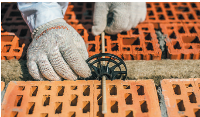
Рис. 13. Установка гибких связей
