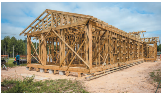
Рис. 18. Установка деревянного каркаса
