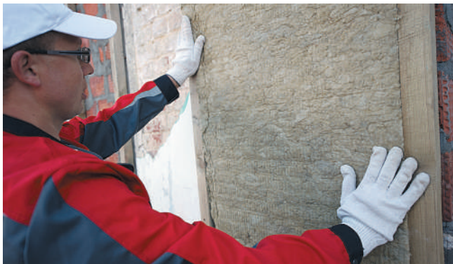
Рис. 2. Монтаж теплоизоляционных плит в вертикальный каркас
