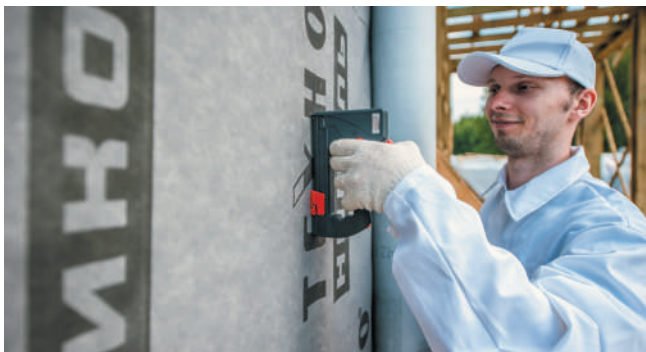
Рис. 21. Монтаж ветро-, влагозащитной мембраны
