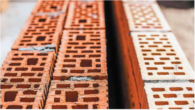
Рис. 10. Монтаж внутренней версты
