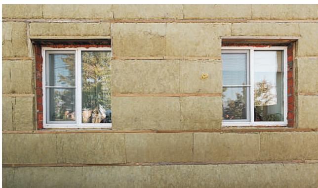
Рис. 4. Монтаж теплоизоляционных плит в горизонтальный каркас
