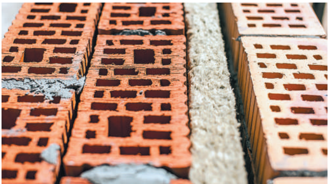
Рис. 11. Монтаж плит теплоизоляции
