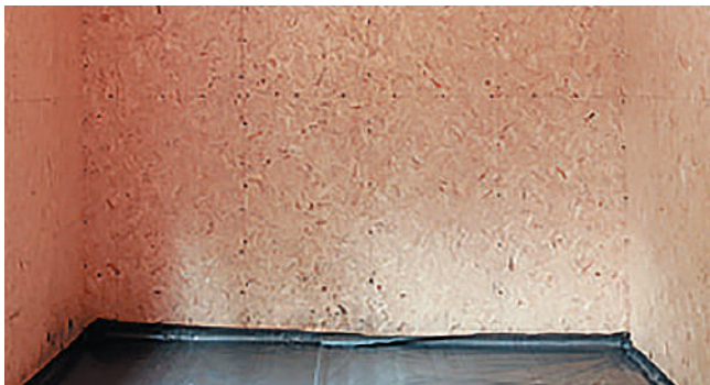
Рис. 23. Обшивка внутренней поверхности стен
