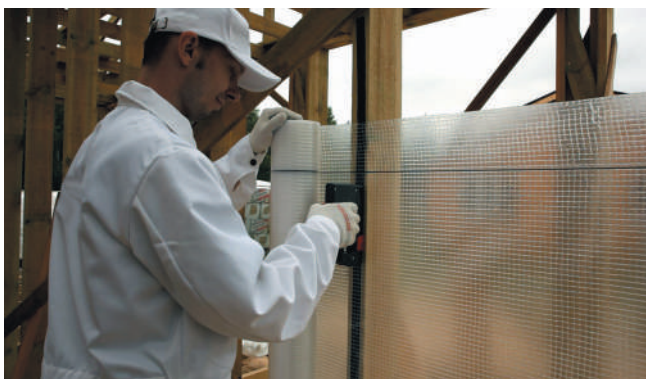
Рис. 19. Монтаж пароизоляционной пленки
