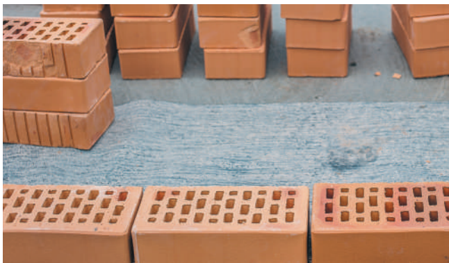
Рис. 7. Гидроизоляционная отсечка
