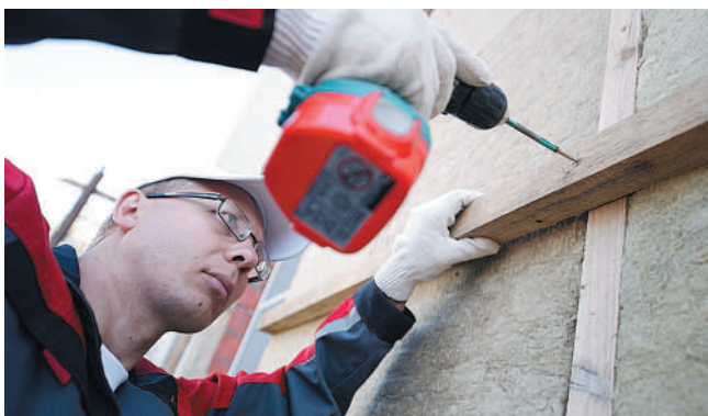
Рис. 3. Установка горизонтального каркаса
