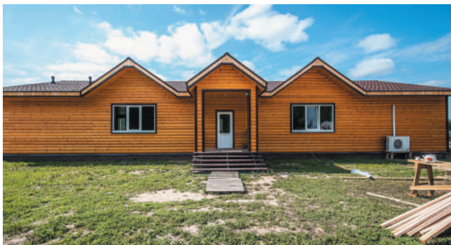
Рис. 22. Монтаж облицовочного материала
