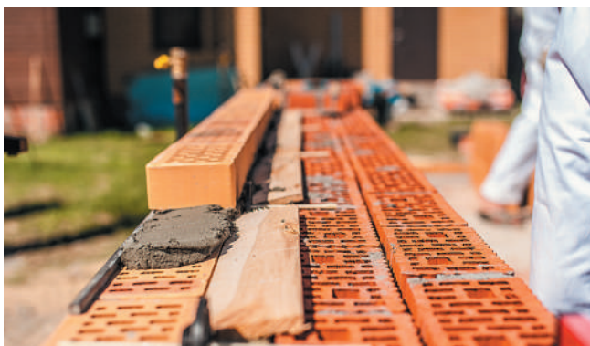
Рис. 14. Монтаж внешней версты после установки гибких связей
