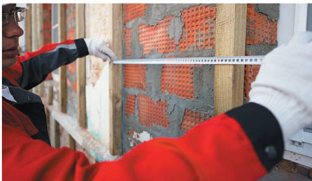
Рис. 1. Крепление вертикальных стоек деревянного каркаса
